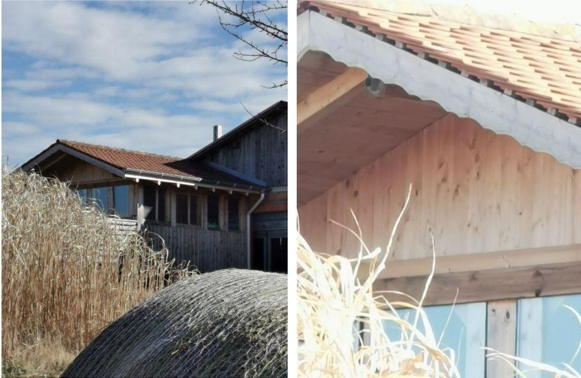
**Abbildung 18: Links: Anbau Westseite; Rechts: Spalten unter Dachziegeln**
