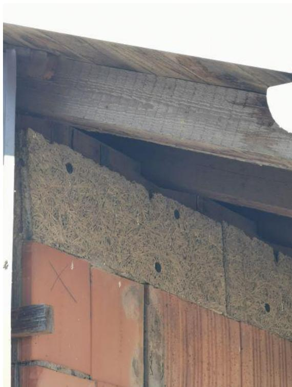
**Abbildung 15: Links: Spalten zwischen Hohlblocksteinen; Rechts: Öffnung zwischen Dach und Außenwand**
