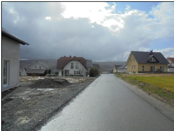
Abb. 5: Entlang der östlichen Plangeietsgrenze verlaufende Asphaltstraße sowie östlich anschließende Wohnbebauungen des Plangebietes „Am Rothenstein“.
